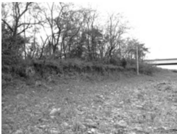
図2 - 1 荒川大橋下流右岸の低位面 II
